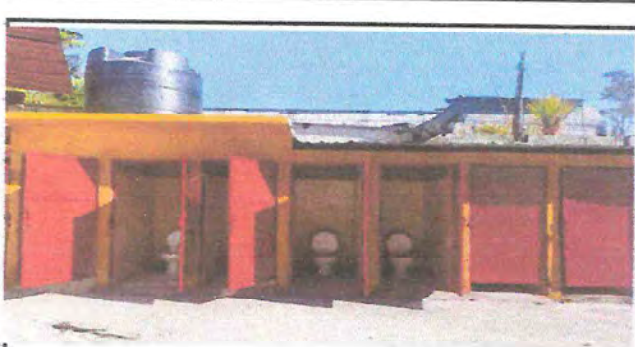
Foto 6: Sustitución de seis inodoros, azulejo y piso. Construcción de terraza e instalación de tubería del tanque a los inodoros
