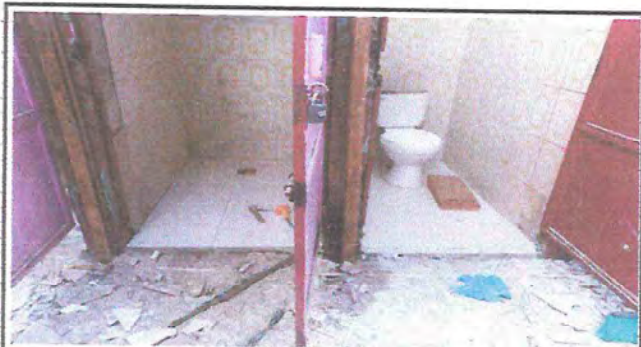
Foto 3: Proceso de sustitución de inodoros y piso, azulejo.
