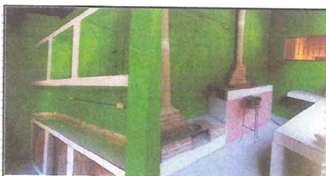
Foto 5: Sustitución de seis estufas rurales, azulejo y piso del área de cocina, construcción de gabinetes para ollas industriales
